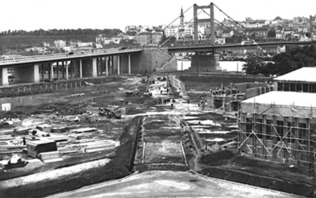
Beogradsko Sajmište u vreme izgradnje
