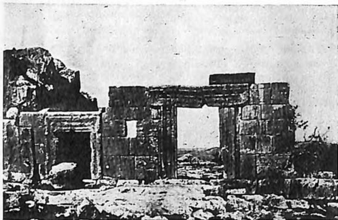
72. Meron, sinagoga, ruševine ulazne fasade.
