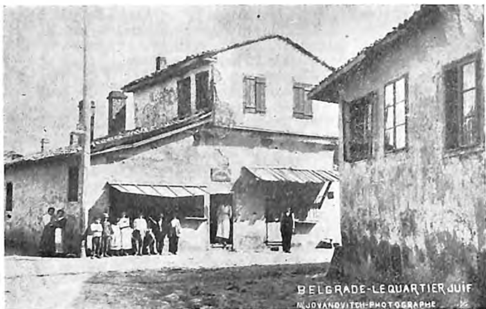
Dve tipične zgrade iz jevrejske mahale
