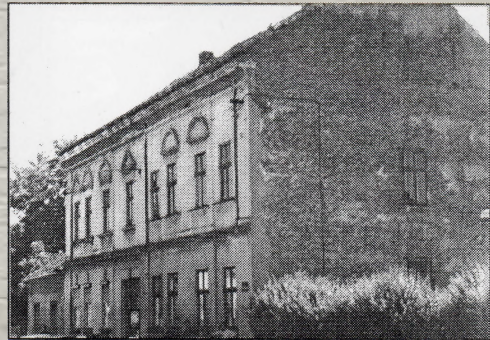
Кућа у којој је становало више јеврејских породица-једни од њих Алкалијеви (данас Ул. Карађорђеви)
