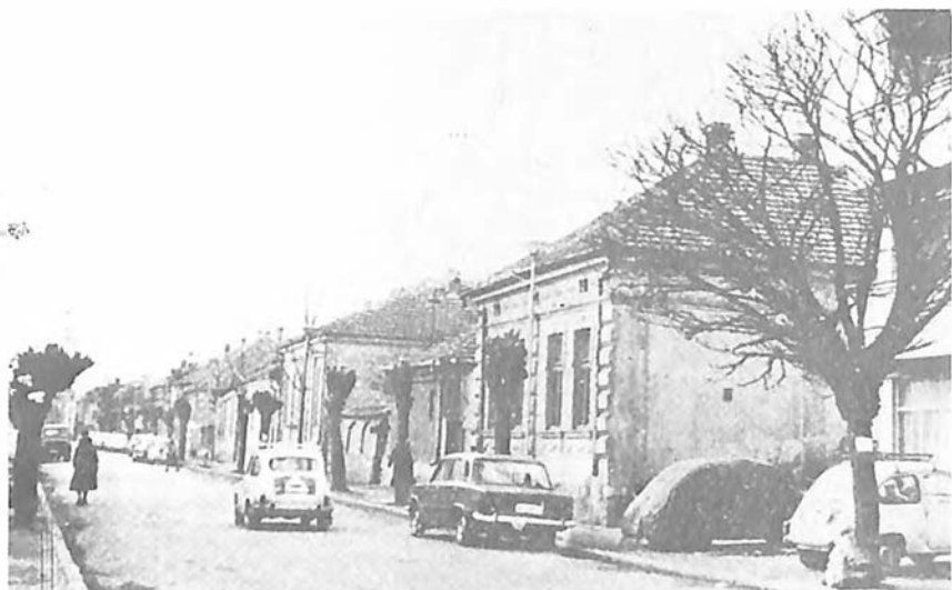
Deo nekadašnje jevrejske mahale u Pirotu u Sarajevskoj ulici
