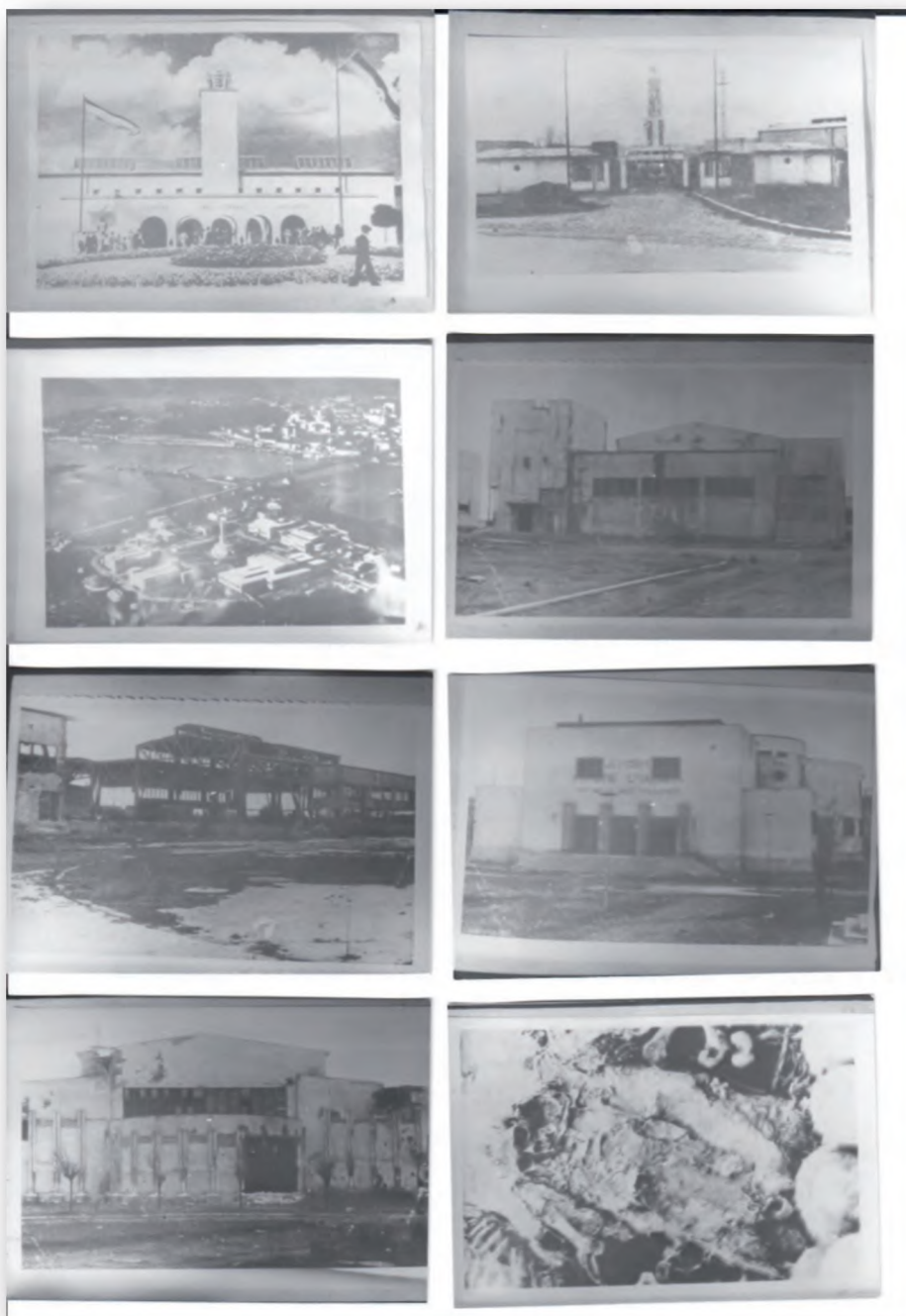
Слика 5 – Сlike логора на Сајмишту (Извор: Јеврејски историјски музеј)
