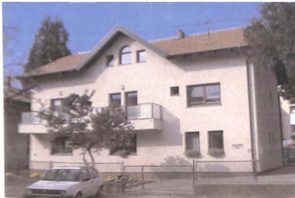
Obnovljeni samostan časnih sestara
