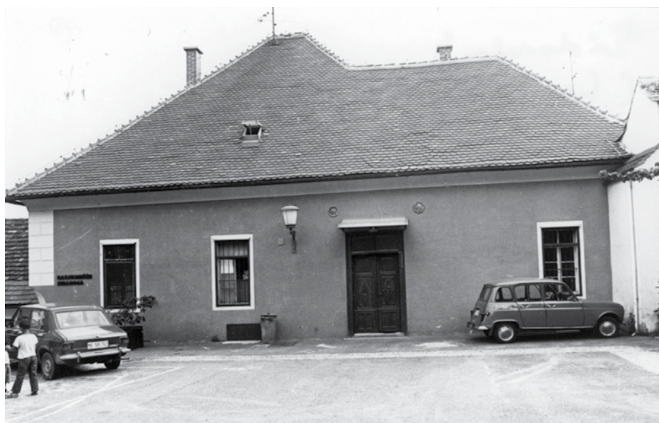
Pogled na sinagogo s severne strani, stanje pred pričetkom obnovitvenih del (Arhiv Sinagoge Maribor, Dokumentacija ZVKD Maribor)
