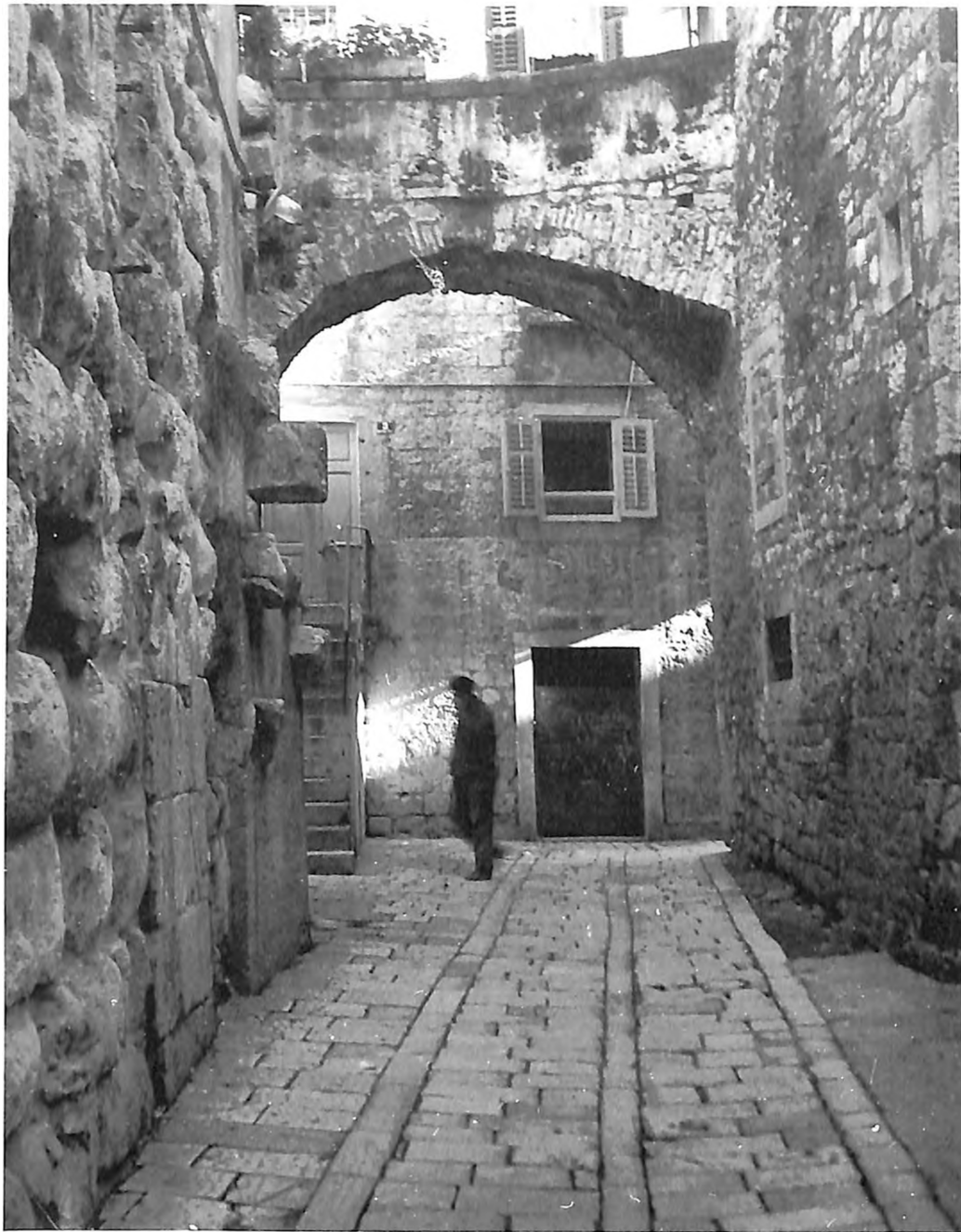
Židovska kula i sjeverni pristup židovskom ghettu
