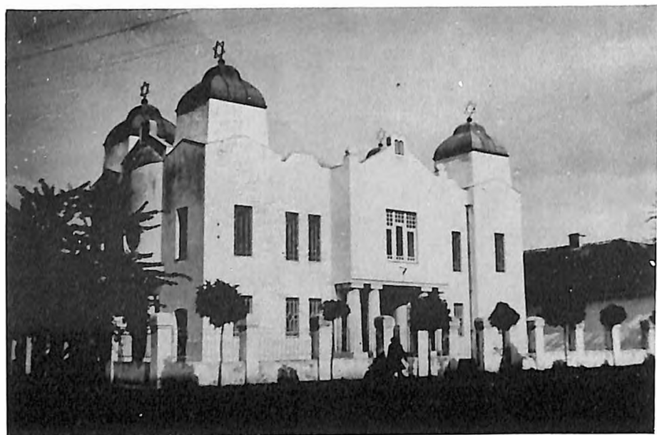
Sinagoga u Novom Vrbasu
