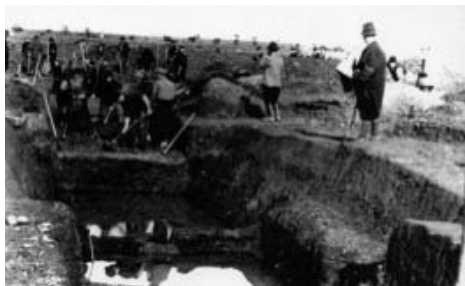
Slika 17: Gradnja jugovzhodnega okopa na avstrijskem Štajerskem
