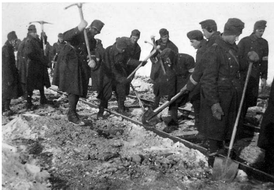
Slika 9: Skrb za železniško infrastrukturo, 1941
