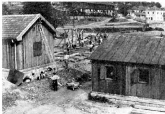
Slika 23: Gradnja barak v enem od taborišč blizu rudnika Bor
