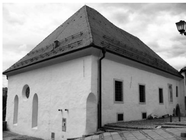
Slika 25: Sinagoga v Mariboru po obnovi (Center judovske kulturne dediščine Sinagoga Maribor, foto: Simona Ort-haber).
