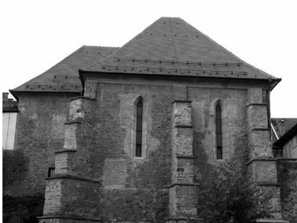
Slika 23: Sinagoga v Mariboru po obnovi (Sinagoga Maribor, foto: Janez Premk).
